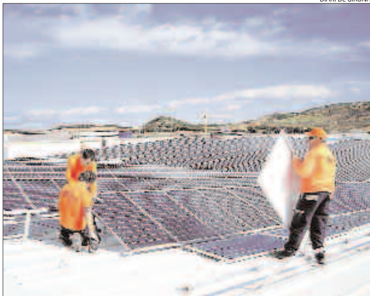
Operaris instal·lant els panells solars a la indústria de Tudela.
